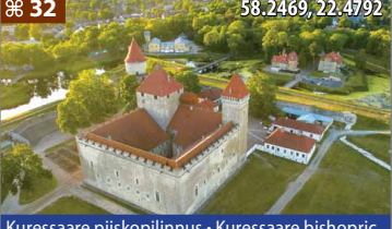
☎ 32 58.2469, 22.4792 Kuressaare piiskopilinnus • Kuressaare bishopric castle-fortification • www.saaremaamuuseum.ee
